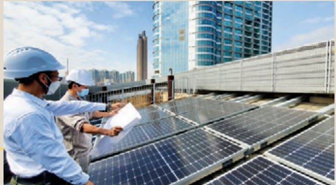
安裝太陽能電池板
